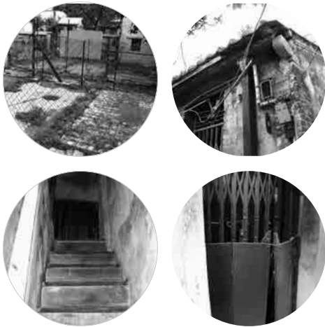
（左上）每間佔地「一分」，約十呎乘廿呎。現在村屋雖已拆卸，但仍可見各屋的排列分隔。 （右上）屋頂上之壓面石梁。 （左下）木樓梯。 （右下）木門外另設門仔。
